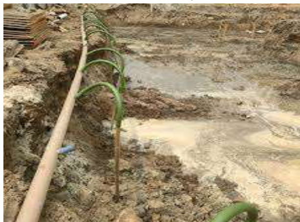
Foto 06 - Rebaixamento de vala com ponteira filtrante
