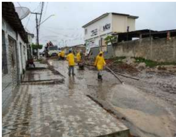
Foto 05 - Rebaixamento de vala com ponteira filtrante
