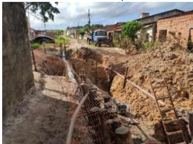
Foto 08 - Rebaixamento de vala com ponteira filtrante
