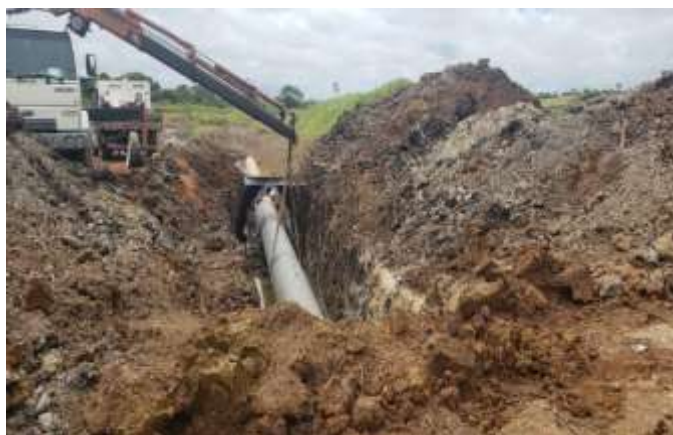
Foto 01 (Travessia BR 101 / TRECHO – 01)
