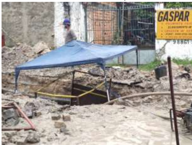
Foto 04 – Rebaixamento de vala com ponteira filtrante
