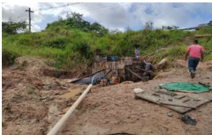
Foto 07 - Rebaixamento de vala com ponteira filtrante
