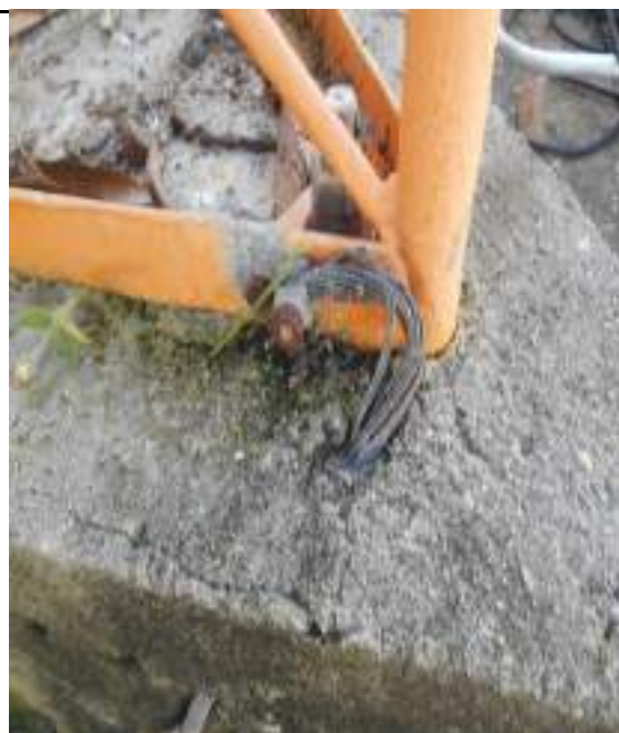
Detalhe do ponto de conexão torre/malha aterramento.
