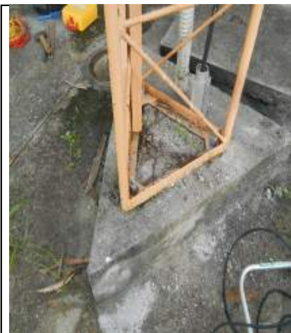
Base da torre e uma das caixas de inspeção.
