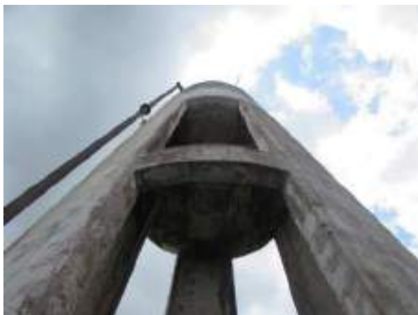
Figura 27 – Vista do anel de viga no trecho entre o P1-P2
