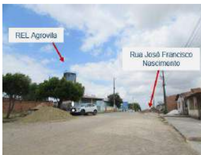
Figura 4 – Vista da Rua José Francisco Nascimento, reservatório Agrovila à esquerda
