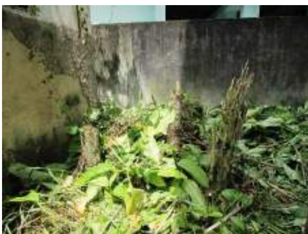
Figura 15 – Tronco de árvore de grande porte, próximo aos Pilares 1 e 3
