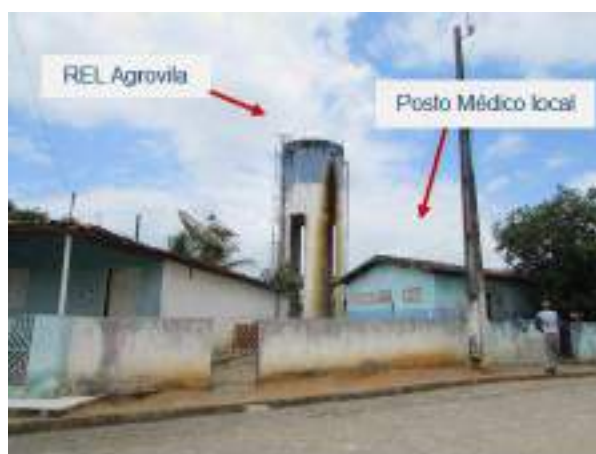
Figura 11 – Vista do reservatório circundado por posto de saúde (destaque) e imóvel particular
