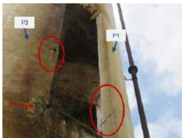
Figura 36 – Vista superior do P3 e P1, ambos com zonas em vias de deslocamento (círculo) na sua extensão e na ligação do P3-Viga (seta)
