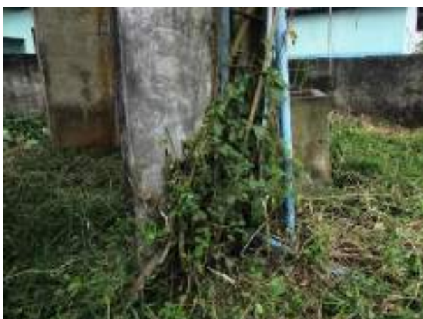
Figura 47 – Detalhe das raízes da vegetação no pé do P5
