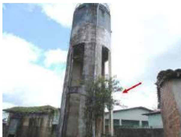
Figura 14 – Vista geral do reservatório com apontamento para vegetação próximo ao Pilar 5 e escada de acesso
