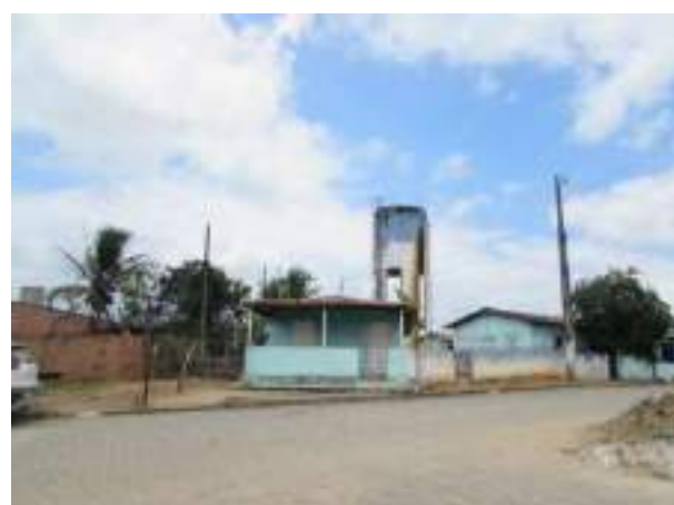
Figura 12 – Vista do REL com demonstração dos imóveis circundantes
