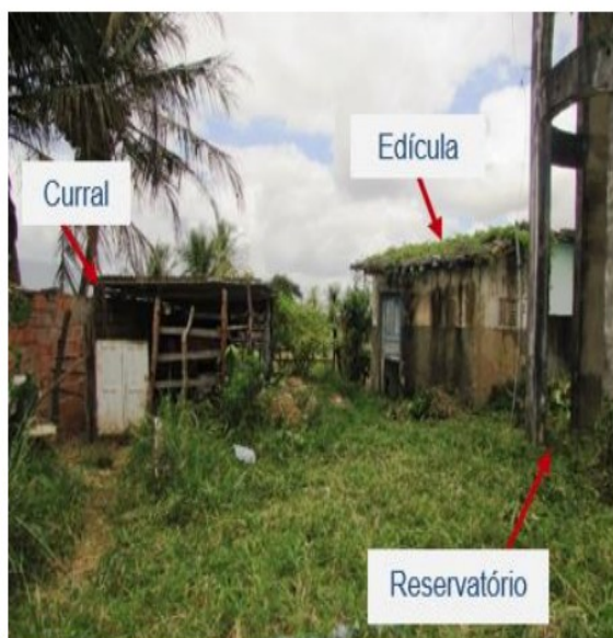
Figura 4 – Vista geral do terreno, entorno do reservatório
