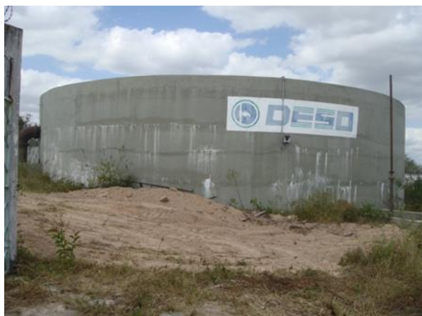
Vista do Reservatório T1
