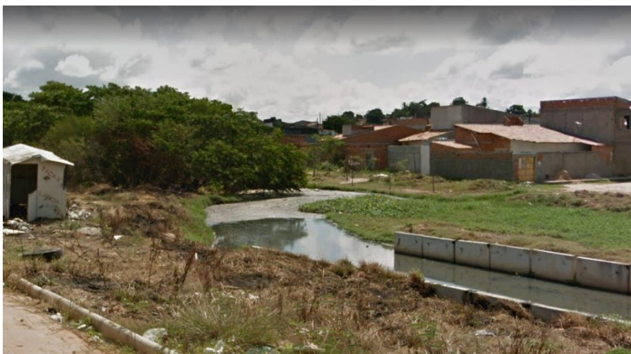
Figura 37 - Trecho final do canal da Av. Presidente Juscelino Kubitschek desaguando em área de manguezal.
