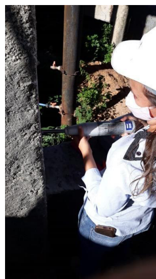
Figura 38 – Ensaio de esclerometria realizado no pilar.
