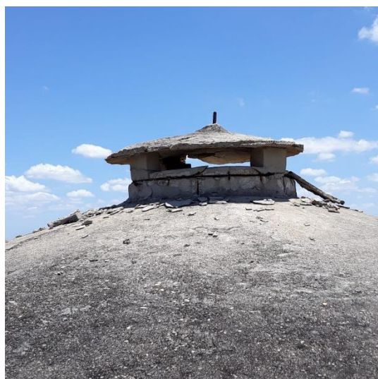
Figura 55 – Face superior da laje da tampa.
