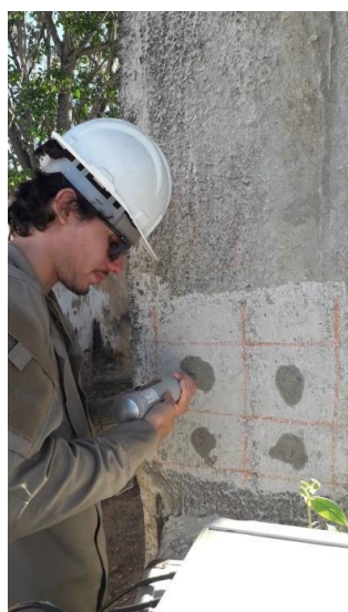
Figura 37 – Ensaio de esclerometria realizado no pilar.
