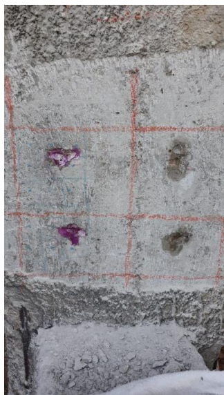
Figura 35 – Execução do ensaio de presença de cloretos na base do pilar P1
