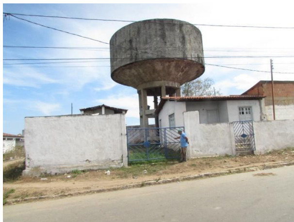
Figura 3 – Entrada do reservatório.
