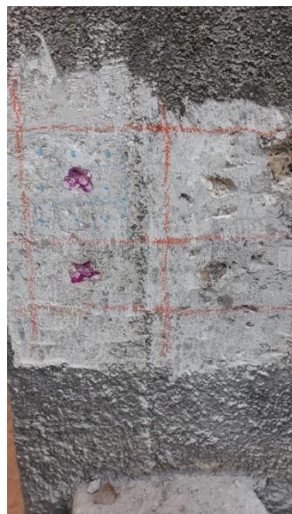
Figura 33 – Execução do ensaio de Carbonatação na base do pilar P6
