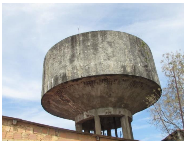
Figura 6 – Vista geral do reservatório.
