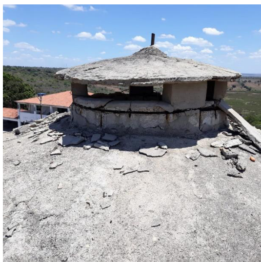
Figura 54 – Face superior da laje da tampa.
