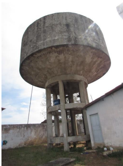
Figura 5 – Vista geral do reservatório.
