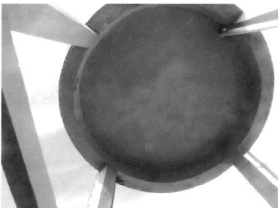
Figura 9 – Vista geral da laje de fundo
