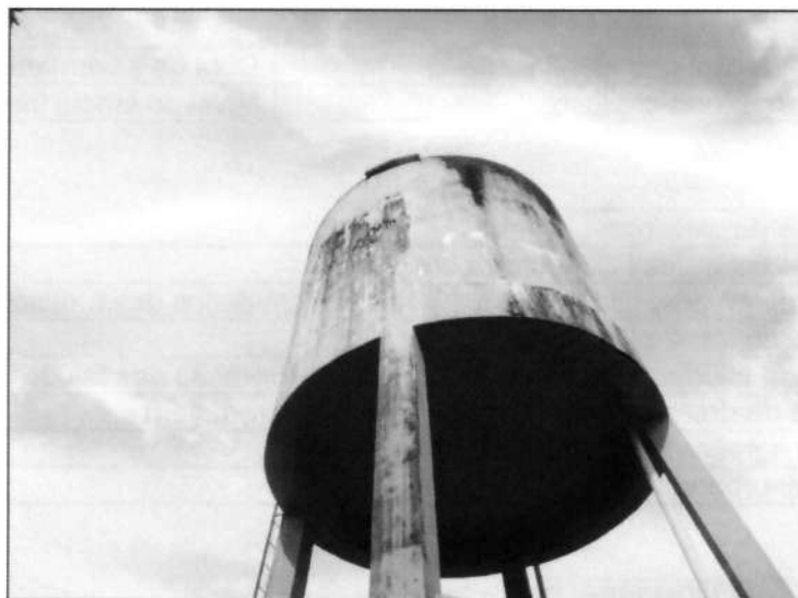
Figura 4 – Vista geral do reservatório
