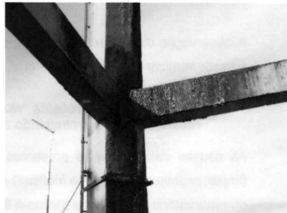
Figura 8 – Pilares e vigas saturadas da água proveniente dos vazamentos da cuba
