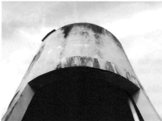
Figura 7 – Infiltração na cuba
