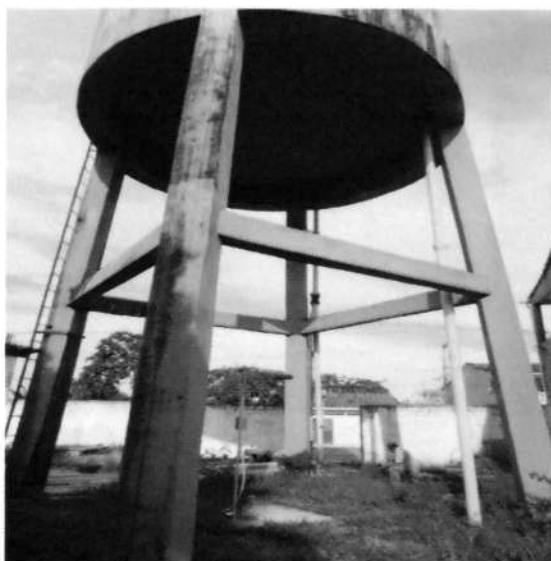
Figura 5 – Vista geral dos pilares e vigas
