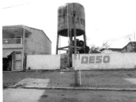
Figura 3 – Entrada do reservatório
