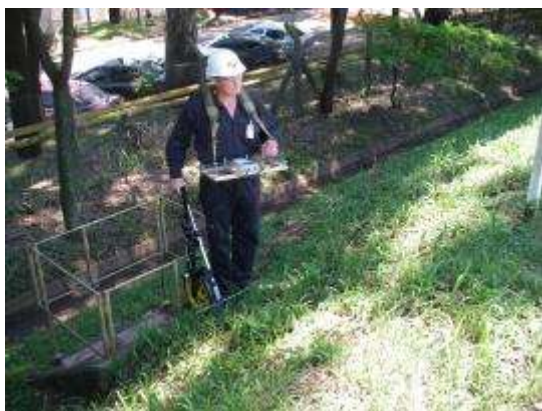
Inspeção em trecho enterrado (M1)
