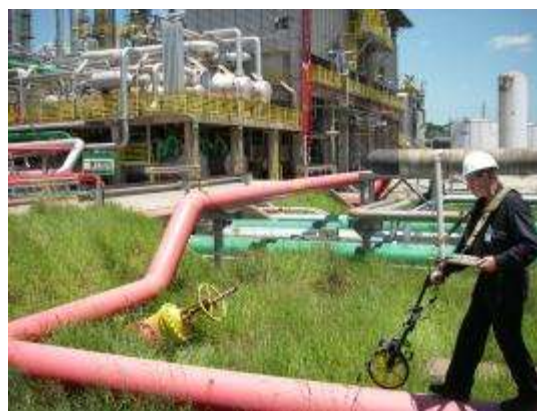
Inspeção em trecho aéreo (M6)
