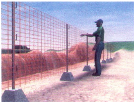
Proteção de vala com tela de PVC
