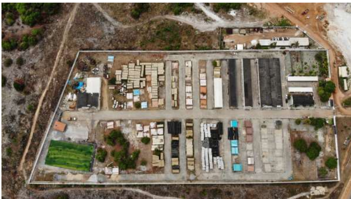
Figura 4: Centro de Distribuição DESO – visão de cima.*
