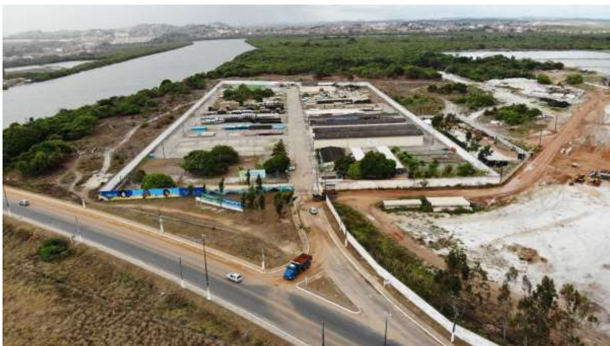
Figura 3: Centro de Distribuição DESO – visão de cima.*
